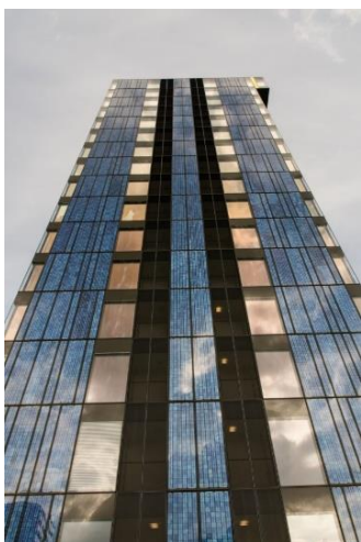
Abbildung 1: BIPV-Fassade Power Tower, Linz
